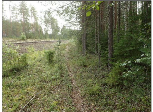
Eteläpäässä vanha ratapohja kulkee ensin maaleikkauksessa ja yhtyy sitten uuteen rataan.
